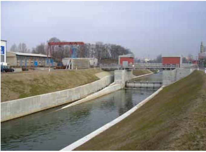
Obr. 3. Nefunkční rybí přechod na obtokovém kanálu Moravy v Olomouci. Ryby z hlavního koryta Moravy nevyhledávají hluboký téměř stojatý podjezový úsek a pod vlastní rybí přechod se jich tak dostane jen minimum
