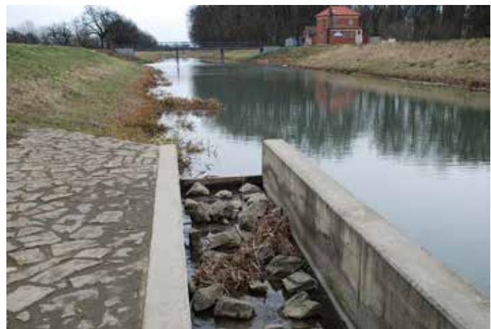
Obr. 1 (vlevo). Technicky nefunkční rybí přechod na Labi ve Vysoké nad Labem
