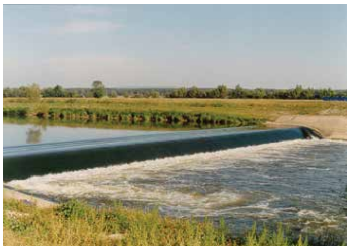
Obr. 7. Betonový práh bez rybího přechodu na řece Moravě ve Tvrdomicích nebyl pro hlaváčku mramorovanou překážkou a nyní je rozšířena až po Hodonín
