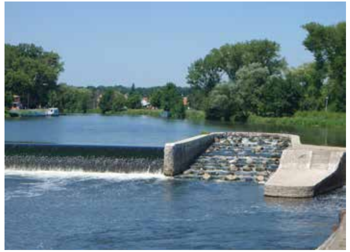
Obr. 4. Průchodný rybí přechod na prvním jezu od Dunaje na řece Dyji v Břeclavi
