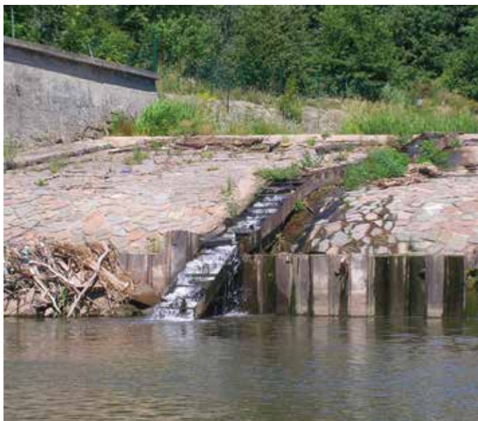
Obr. 1 (vlevo). Technicky nefunkční rybí přechod na Labi ve Vysoké nad Labem
